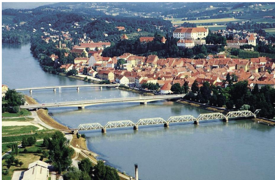
Slika 19 • Most za pešce, cestni most in železniški most na Ptujju
