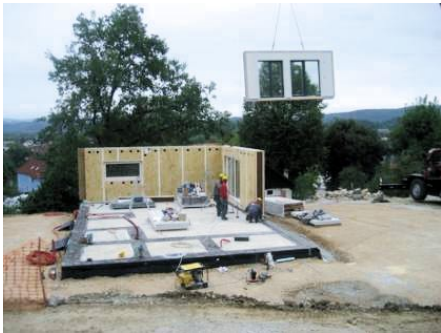
Slika 7 • Montaža objekta je hitra, brez odpadkov in natančna
