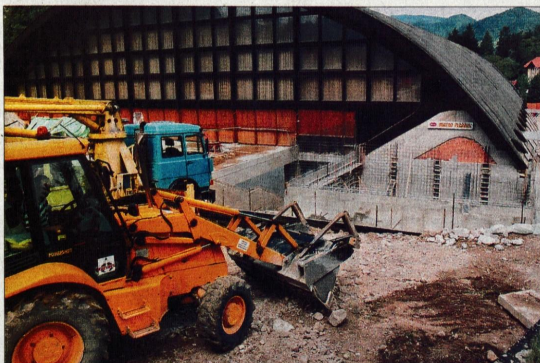
Gradbena dela v blejski športni dvorani in v okolici zadnje tedne potekajo v pospešenem ritmu.
