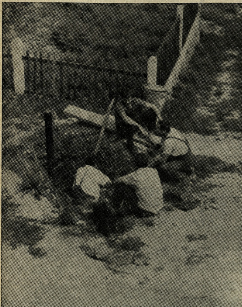
DELAM, DELAM, DELAM, ... TELEFONSKO OMREŽJE PODJETJE ZA AVTOMATIZACIJO PROMETA — LJUBLJANA
