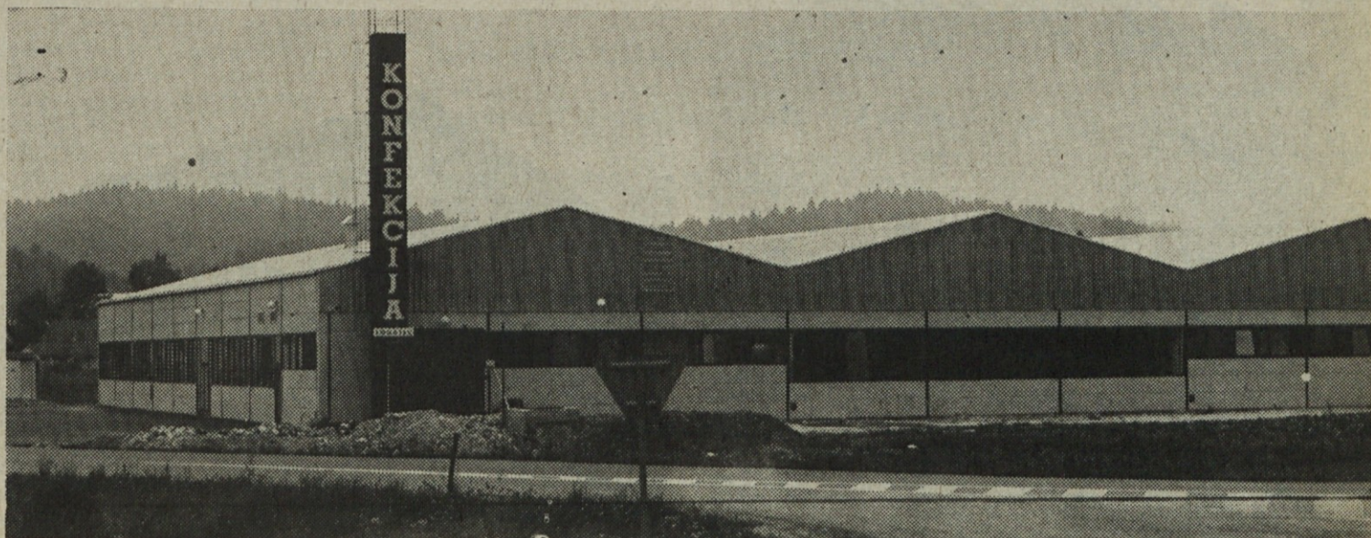
Veliki napori in tudi občutna odrekovanja delovnega kolektiva Konfekcija so po 15 letih omogočila gradnjo tega industrijskega objekta v Logatcu
