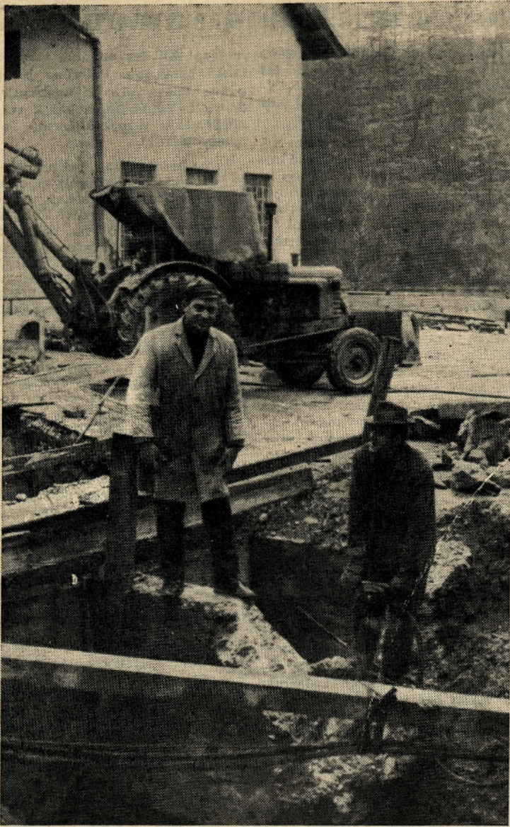
▲ Urejanje kanalov med kotlarno in plemenitilnico I
