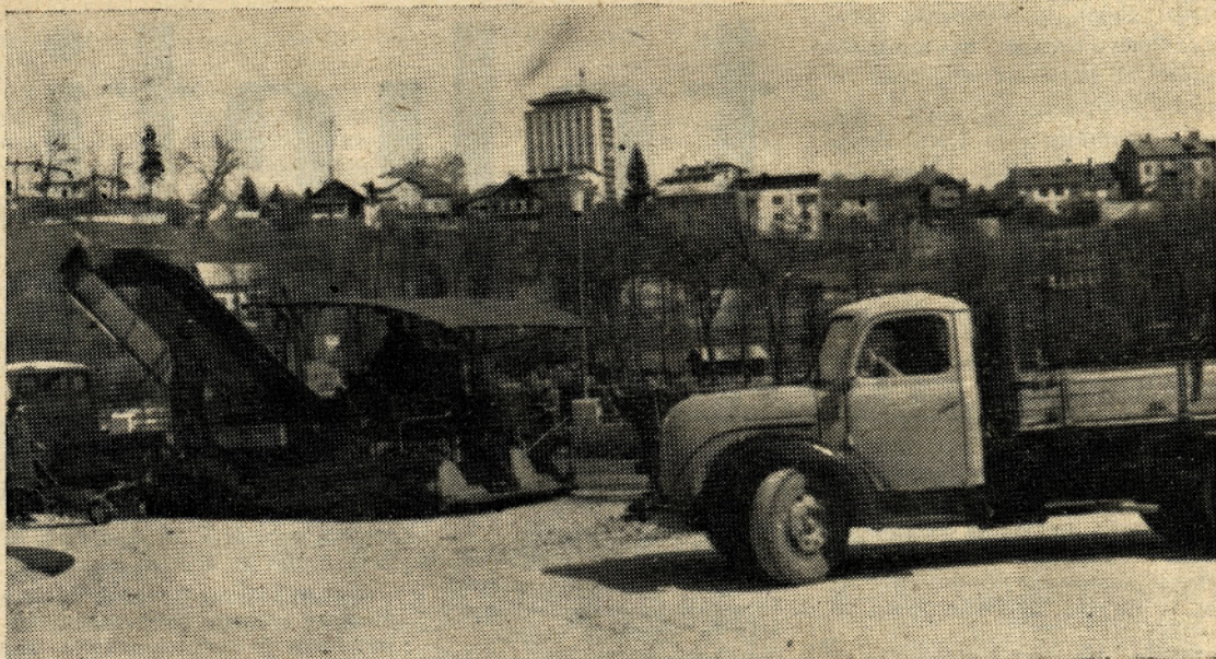
Polnjenje specialnega stroja za asfaltiranje
