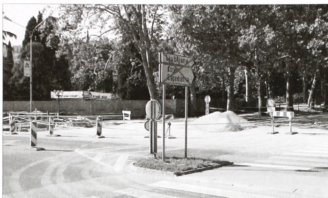
Portorož je trenutno veliko gradbišče. (foto: až)
