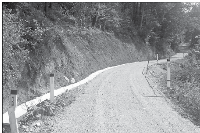
Cesta po prvi fazi sanacije
