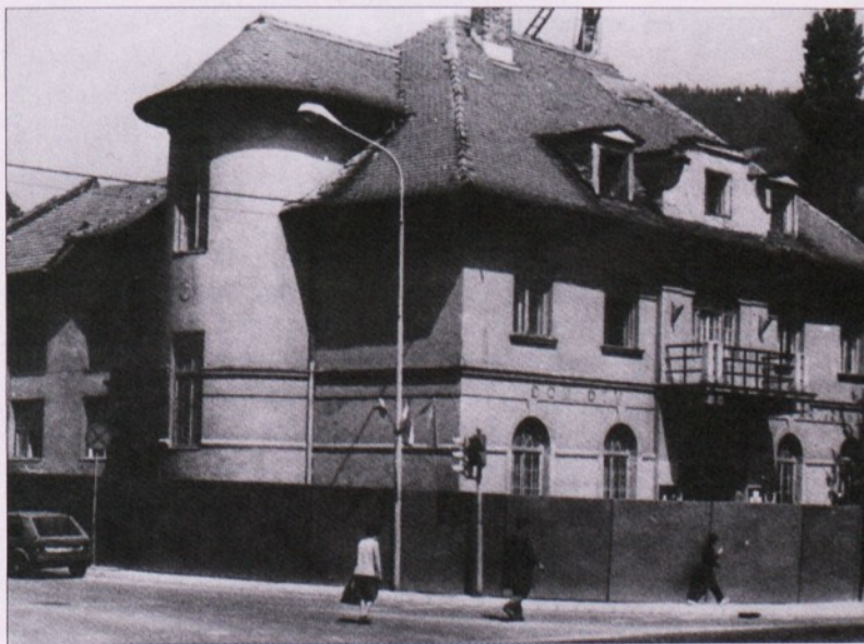
Prenova stavbe, 1982 (vir: Mislinjska dolina, marec 1986)
