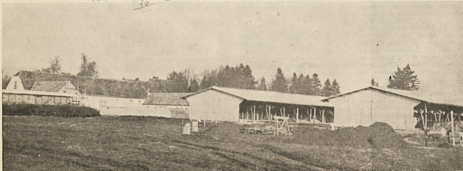
Pogled na gradbišče pitališče na DE Pragersko
