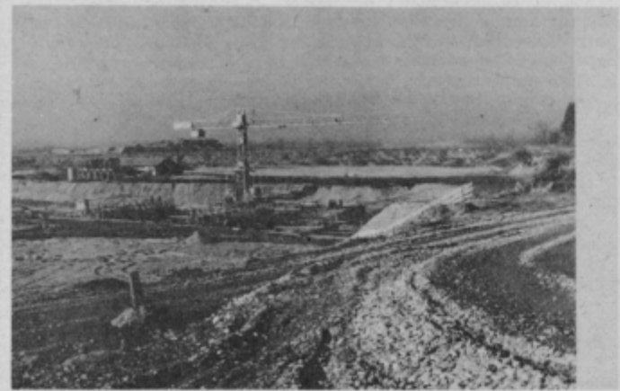
Temelji šestih zapornic na Dravi pri Markovcih. Vanje bo vgrajeno 50.000 kub. m armirane betona.
