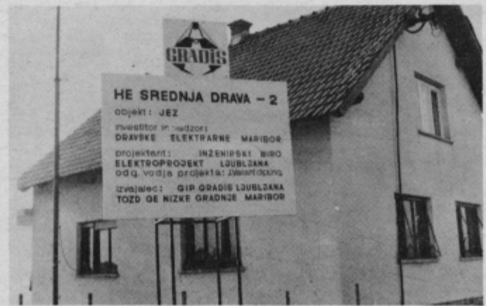
Uprava gradbišča v Markovcih.
