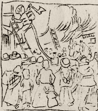
POŽARNA BRAMBA ŽE GASI, KOT PEKEL HIŠA SE KADI.
