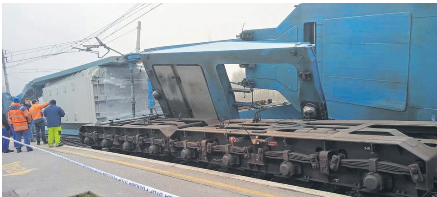
Konec tega tedna bodo v Zidanem Mostu predvidoma začeli dvigovati še transformatorsko postajo, ki je zdrsnila z vagona.
