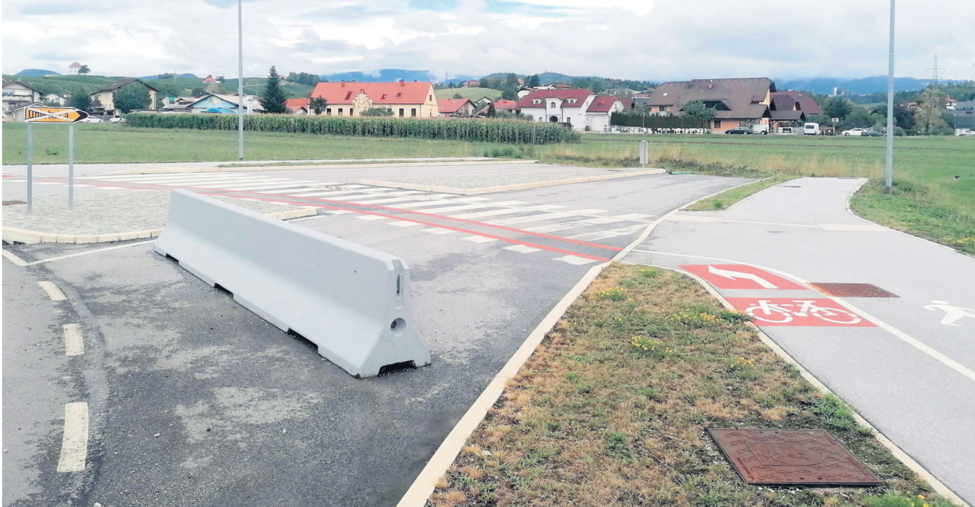
Če bo vreme dopuščalo, se bo gradnja obvoznice začela v naslednjih dneh. (Foto: Občina Slovenske Konjice)
