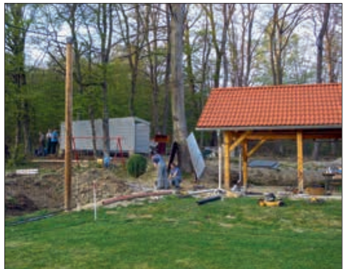
Postavljanje nadstrešnice in garaže
