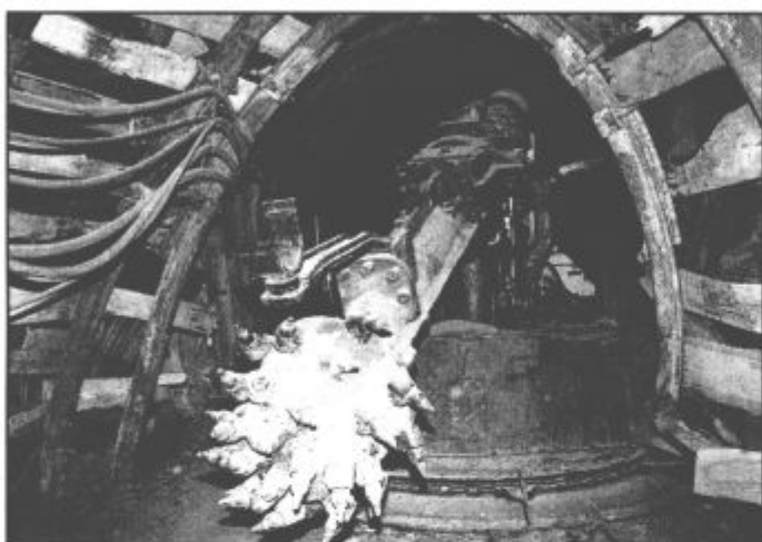
Napredovalni stroj za izdelavo jamskih prostorov, tudi iz obdobja po letu 1960.
