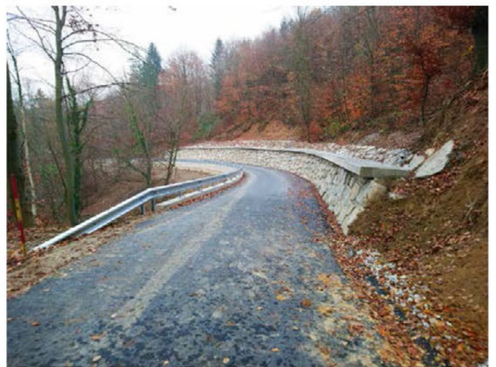
V novembru je bila precej zahtevna naložba uspešno končana in cesta je že prevozna do vrha.
