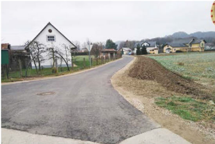
Kanalizacija in nekatera druga dela v Borštu so končana.
