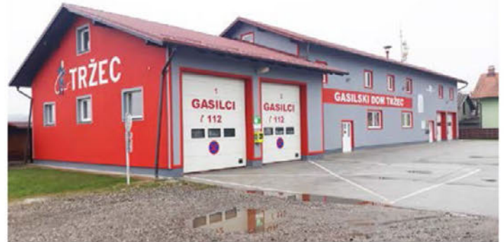
Trževski gasilski dom z novo zunanjo podobo Foto: arhiv PGD Tržec
