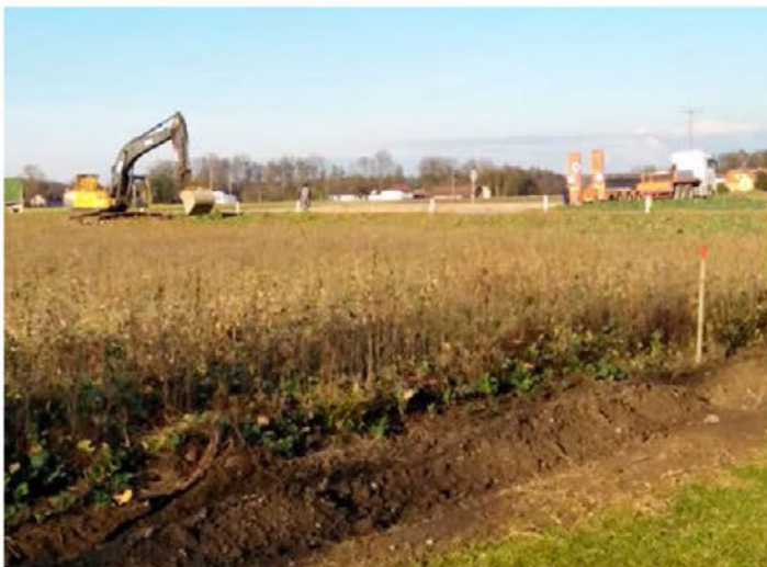
Na območju Občine Videm poteka izgradnja daljnovoda Cirkovce–Pince.
