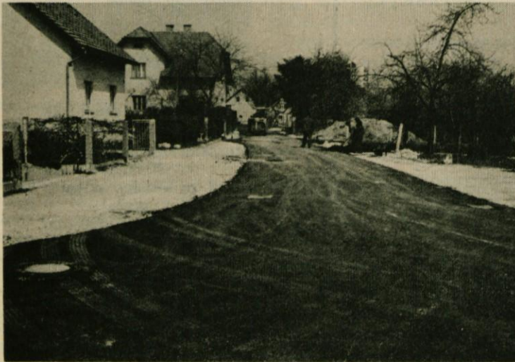
Ulica Antona Skoka v Domžalah je ob materialnih prispevkih občanov dobila novo asfaltno prevleko
