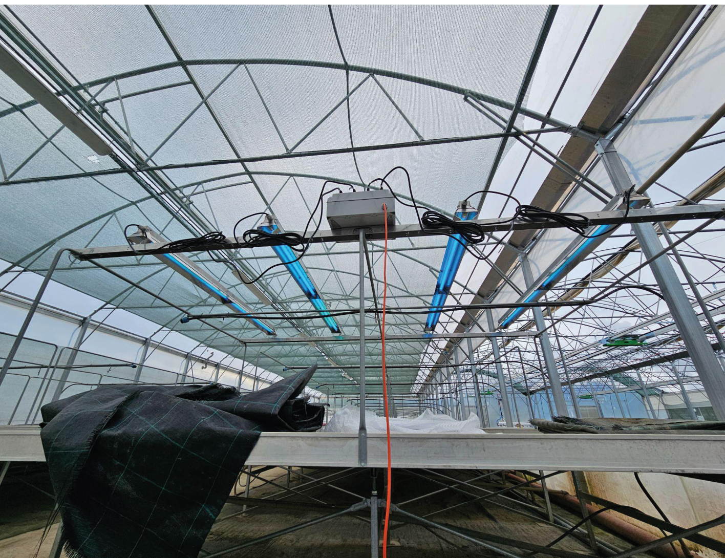
Slika 7: Stacionarni sistem za UV-C osvetljevanje v rastlinjaku Inštituta za hmeljarstvo in pivovarstvo Slovenije
