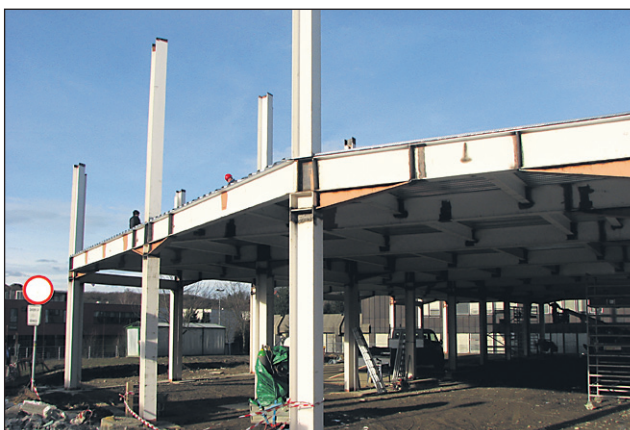
Ob stavbi ptujškega šolskega centra že nastaja prizidek, s katerim bodo pridobili nove prostore za učne delavnice in servisne storitve.
