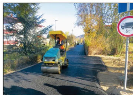
Asfaltiranje odseka ceste Polter v Hajdošah
