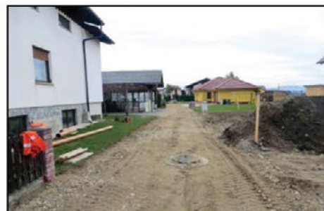
Izkop na lokaciji Draženci pri Feršu
