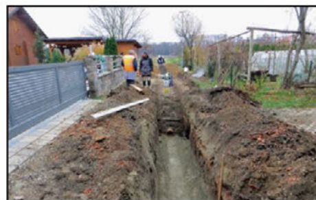
Izkop – kanalizacijska dela v Skorbi
