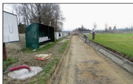
Prva pripravljala dela – polaganje robnikov na novi atletski stezi v športnem parku Hajdoše
