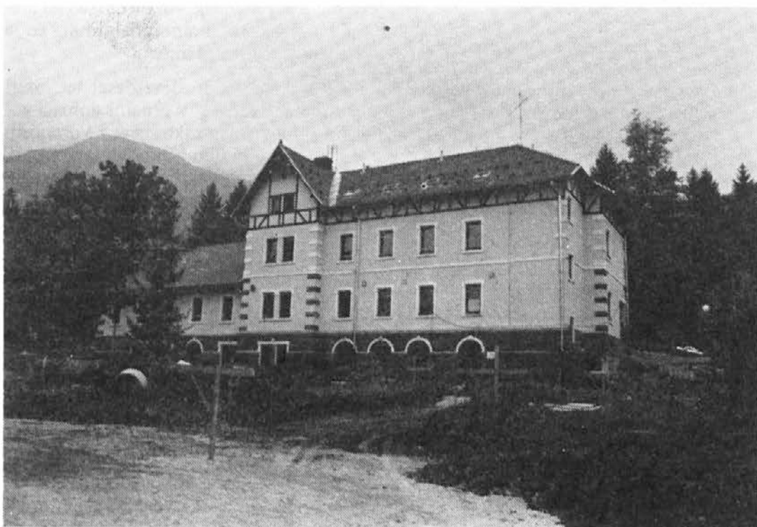
Začetek del ob prenovi Rimskega vrelca
