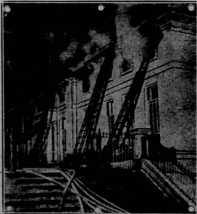
Dan pred Božičem je izbruhnil požar v eksekutivnem delu Bele hiše. Par dni zatem je začelo goreti v Kapitolu. Požar je bil v obeh slučajih pravčasno pogasjen. Slika nam kaže gaisanje ognja v eksekutivnem posloppju.
