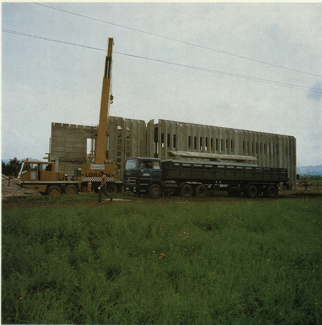
Nov objekt iz področja industrijske gradnje s predfabriciranimi elementi – RTP NOVO POLJE 110/10 kW.
