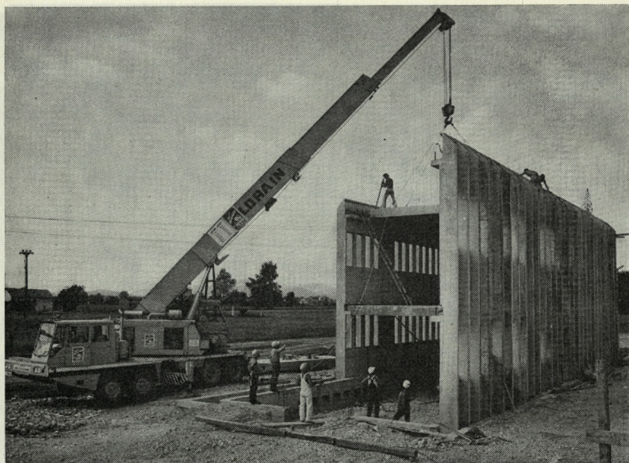
Montaža predfabriciranih elementov razdelilne transformatorske postaje 110/10 KW v Novem polju
