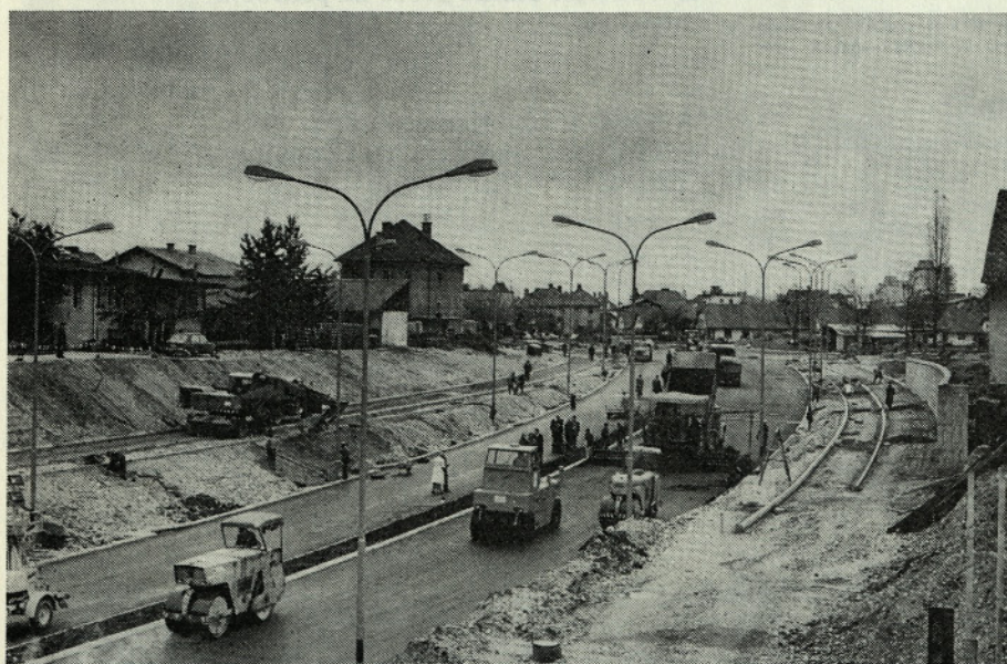
Izvajamo modernizacijo in rekonstrukcijo mestnih cest v okviru desetletnega programa izgradnje ljubljanskih obvoznic. Na posnetku Drenkova cesta med Celovško in Titovo ceto — polaganje asfalta na novi štiripasovnici
