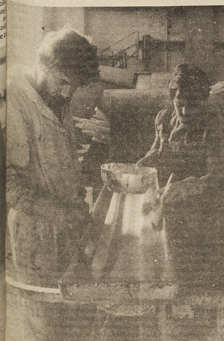
Ipko ima z Elanom pogodbo o izdelavi raznih športnih orodij. Na sliki: laminiranje izdelka za elan.
