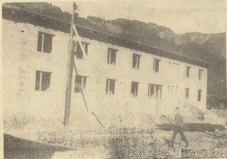
Nova kotlovnica na Jesenicah
