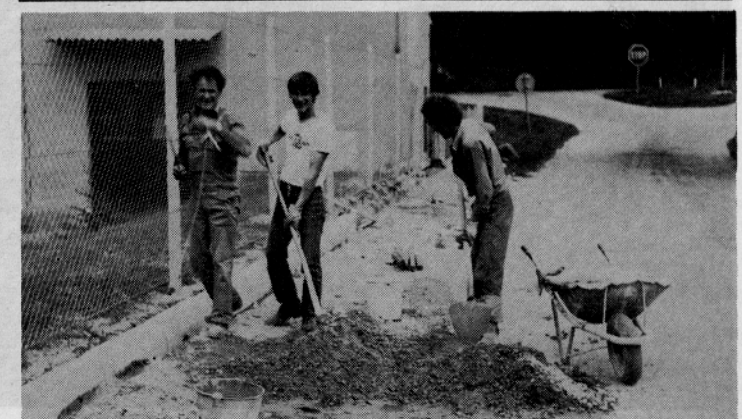
Gradbena dela se v Mojstrani zaključujejo
