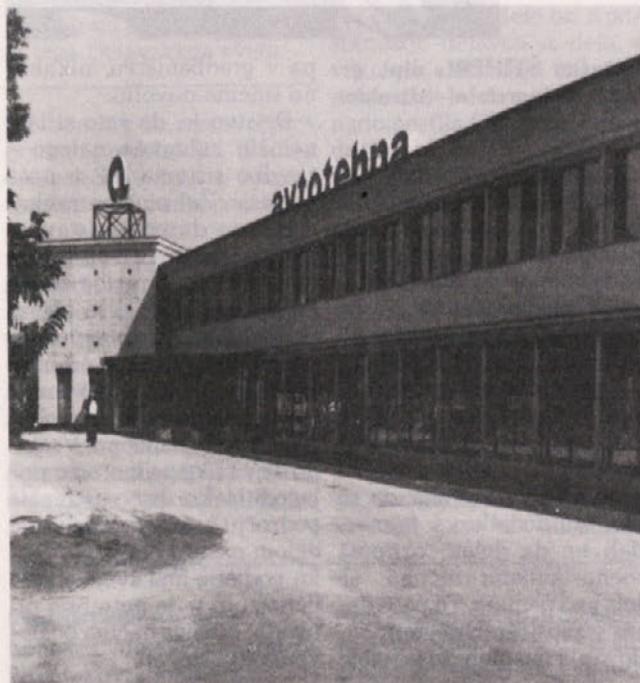
Dela na objektu Avtotehne so v zaključni fazi.
