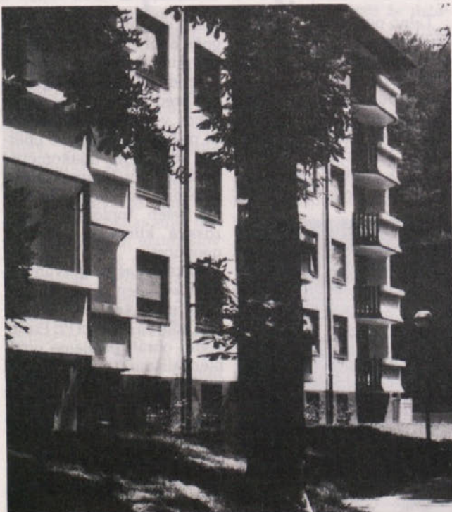
Stanovanjski blok na Rakovniku je že vseljen.
