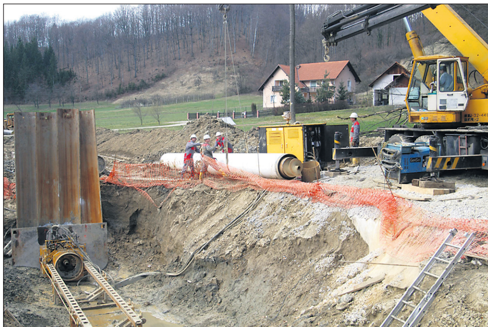
V teh dneh delavci podjetja IMP Ljubljana in podizvajalcev gradijo vzporedni plinovod proti Rogatcu.
