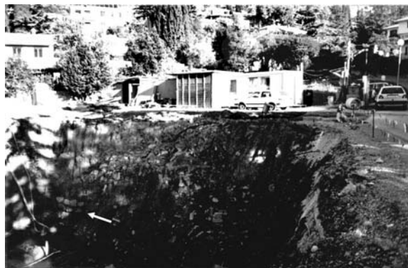
Sl. 3: November 1998. Situacija po izkopu gradbene jame. S puščico je nakazan potek neraziskanega zidu (fotografija: Marko Stokin).
