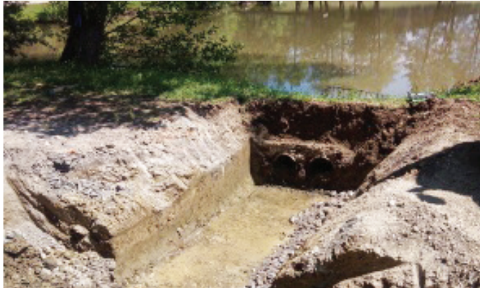
Sanacija propusta pri ribniku na Prevojah.
