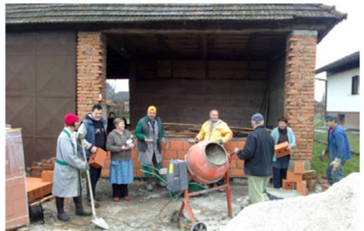
Obnova stavbe Petrove domačije
