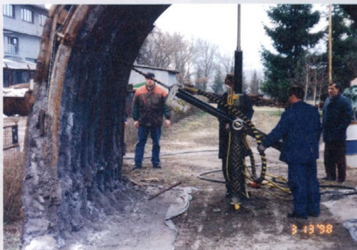
Tehnologija, ki jo uvajamo v jame, zahteva kvalitetne vrtalne garniture. Na fotografijah zgoraj in spodaj je prikazano vrtanje sidrnih vrtin.
