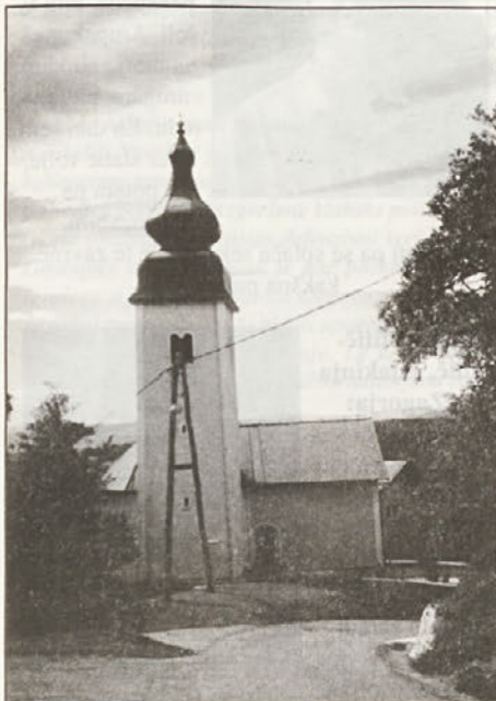
Obnovljena cerkev Sv. Petra in Pavla iz 12. ali 13. stoletja.
