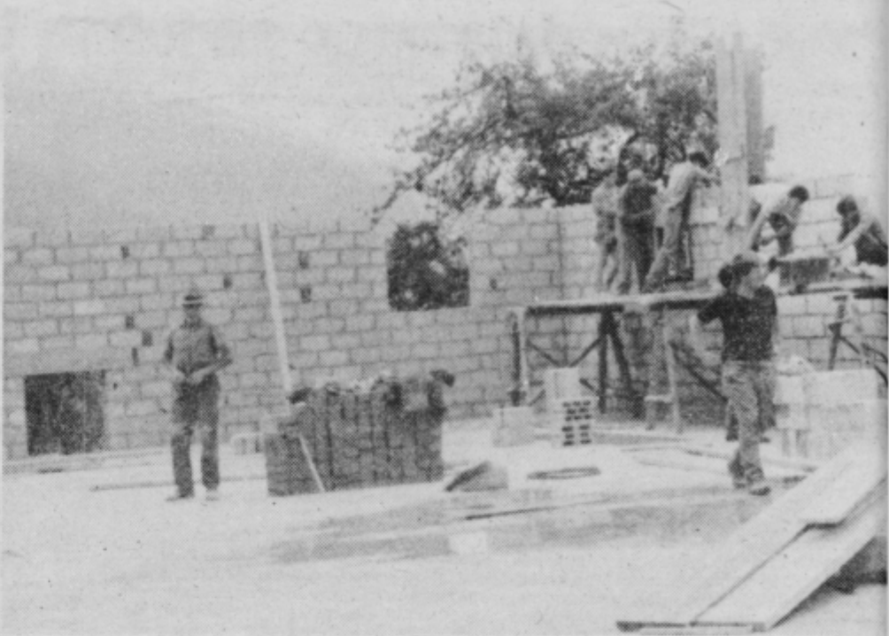
Na gradbišču vsak dan mrgoli delavcev od vsepovsod. Na posnetku so se mladi sovaščani dimenzije novega hleva so spoštljive: 24,5 krat 14 metrov. Prostora bo za 34 glav živine.
