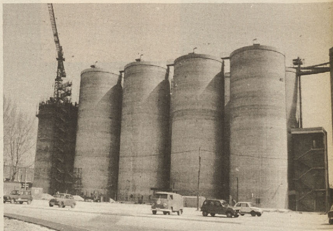
Izgradnja žitnih silosov na Spodnji Hudinji v Celju dobro napreduje, izvajalci so izvlekli opaže oziroma zabetonirali celice v rekordnih sedmih dnevih. Predviden zaključek vseh del je konec meseca junija, tako da bodo lahko sprejeli že letošnji pridelek žita.
