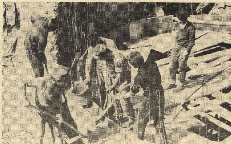
Betoniranje komore je zahtevno delo
