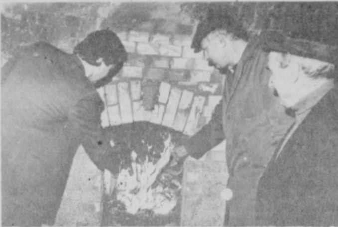
Priziganje peči po opravljenem remontu
