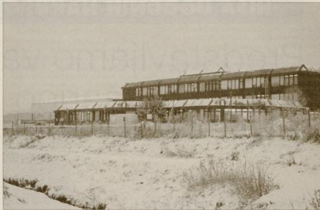
Že čez nekaj mesecev bo za poslopjem Šolskega centra veliko gradbišče.
