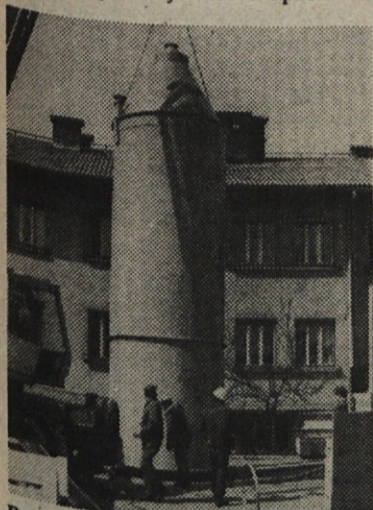
Betonarna je prirejena za vremenske razmere v Iraku. Silos je zaradi prihranka prostora pri transportu narejen montažno, saj se zgornja polovica silosa natakne na spodnjo
