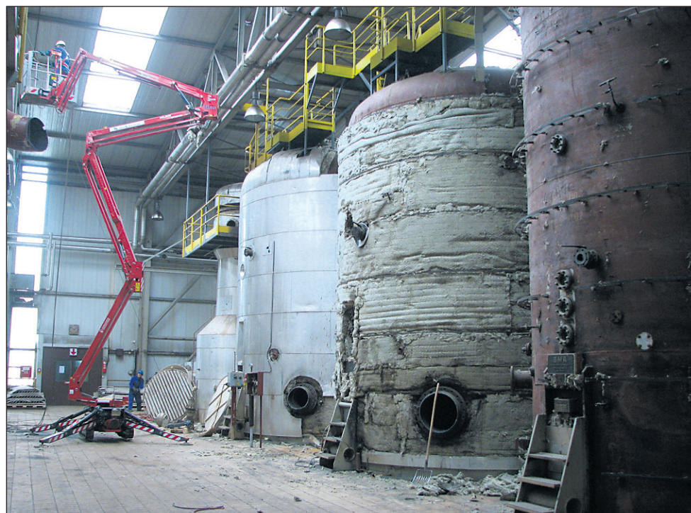
Delo pri demontaži je precej nevarno, saj tudi na višini odstranjujejo velike kose opreme.
