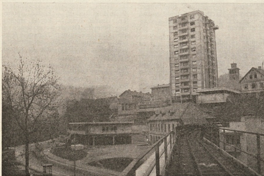
Stanovanjska stolpnica v Hrastniku v gradnji. Investitor je stanovanjsko podjetje Hrastnik, stanovanja pa bodo namenjena članom delovnih skupnosti s področja Hrastnika.
