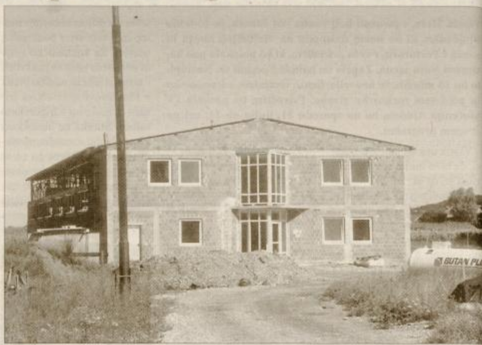
Industrijska cona v Forminu že dobiva pravo podobo, saj je prvi od treh načrtovanih objektov že pod streho.
