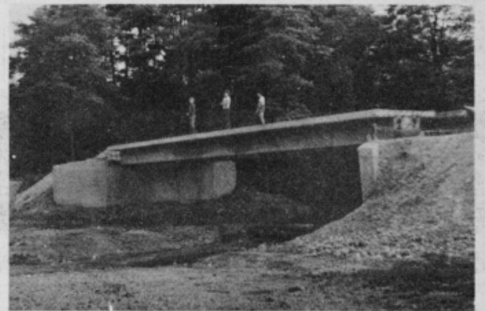
Novi most v Tržiču, ki so ga zgradili, poleg prostovoljnega dela občanov, tudi s krajevnim samoprispevkom.
