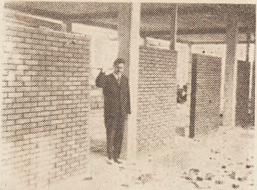
Del zida iz klinkerja ter delovodja tov. Spindler, ki je ponosen na kvaliteten izdelek — seveda je ta slika iz Nemčije
