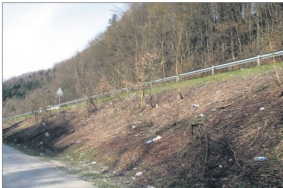
Letošnja čistilna akcija v Podlehniku bo nekaj posebnega; prostovoljci bodo namreč čistili jarke, mulde in cestne kanale za odvodnjavanje (ter krpali manjše poškodbe na bankinah), ki so po hudi zimi in številnih pluzenjih polni peska in zemlje. Kot je povedal župan Maučič, pa ne bodo več na svoje stroške čistili z odpadki dobesedno zasutih obcestnih površin na lokaciji starega mejnega prehoda Gruškovje, ki so itak v državni lasti (na posnetku).
