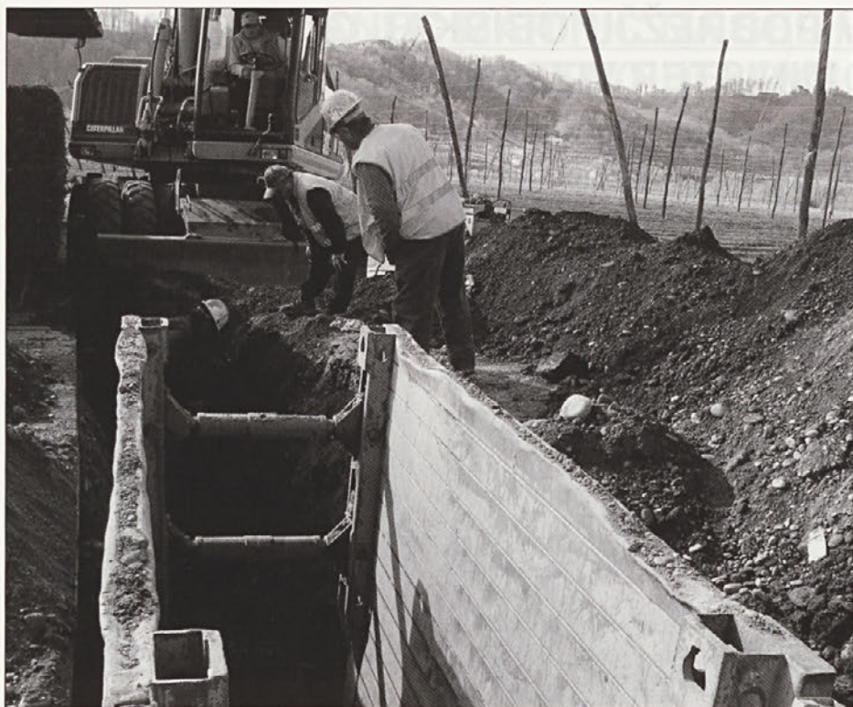
V zemljo je potrebno spraviti ogromne kanale ...
