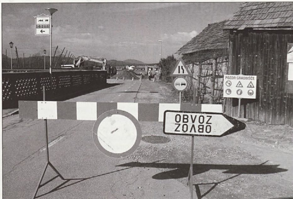
V Vidmu, od pokopališča do Vrbanove kapele, že gradijo novi krak kanalizacijskega sistema.
