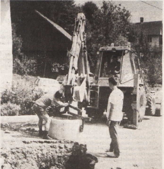
KANALIZACIJA IN ČISTILNA NAPRAVA - V Osilnici te dni dokončujejo prenovilo čistilne naprave in gradnjo kanalizacije za Osilnico in Sela (na fotografiji). Sedanja čistilna naprava pri obratu LIV ni pravilno delovala in jo je bilo treba dograditi oz. popraviti, hkrati pa bodo nanjo priključili kanalizacijo iz omenjenih dveh vasi. (Foto: J. Primc)
