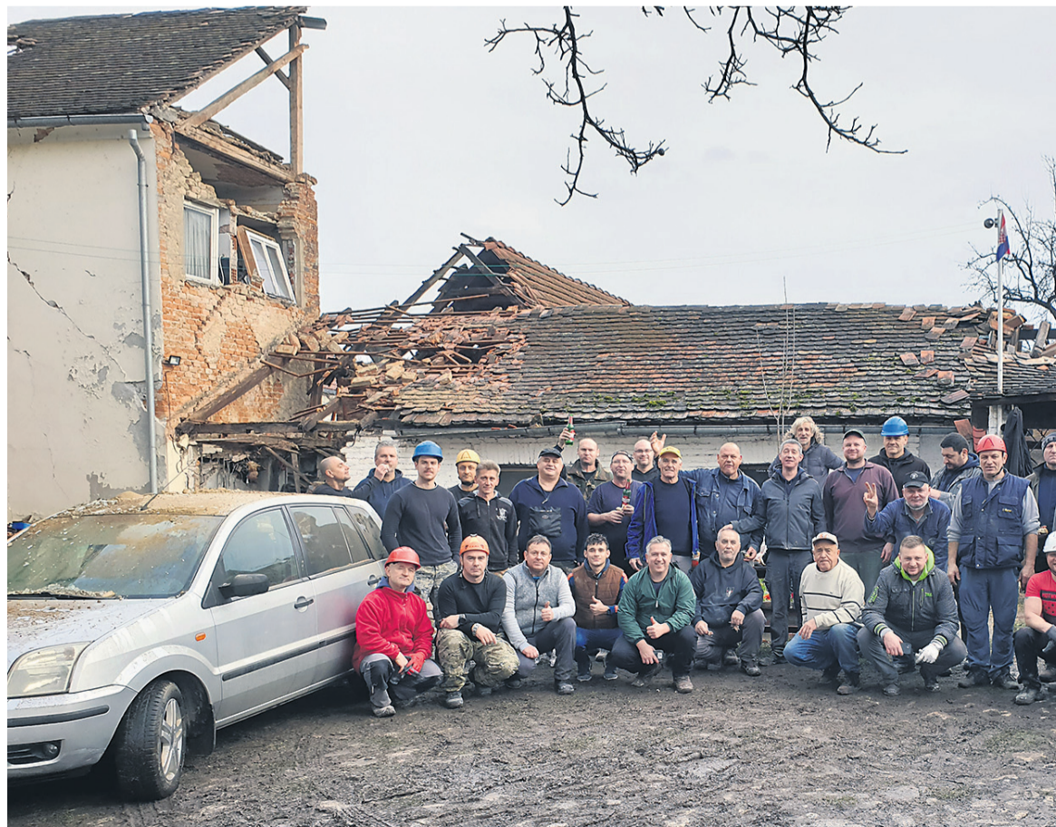
Pri odstranjevanju ruševin so Vidničevim že pomagali sorodniki in dobri prijatelji.
