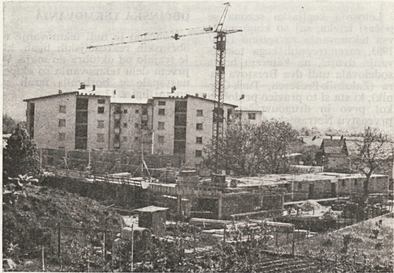
Gradbišče doma upokojencev v Cerknici
