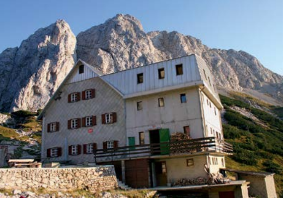
Nad Kokrskim sedlom se dviguje razčlenjena severozahodna stena Kalške gore. Foto: Andrej Trošt
