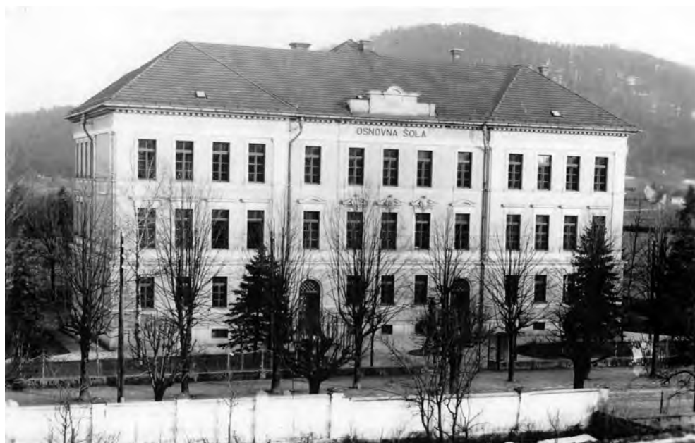
Poslopje nove ljudske šole na Vrhniki, zgrajene v letih 1904–1905 (foto v MDV).
